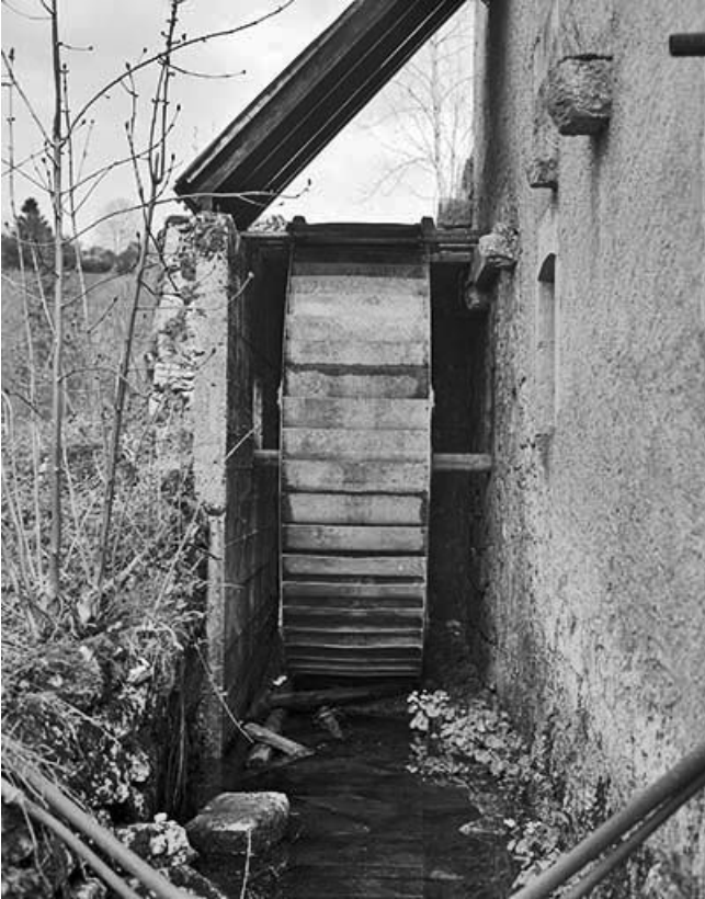
Roue à aubes ou à " augets ".
