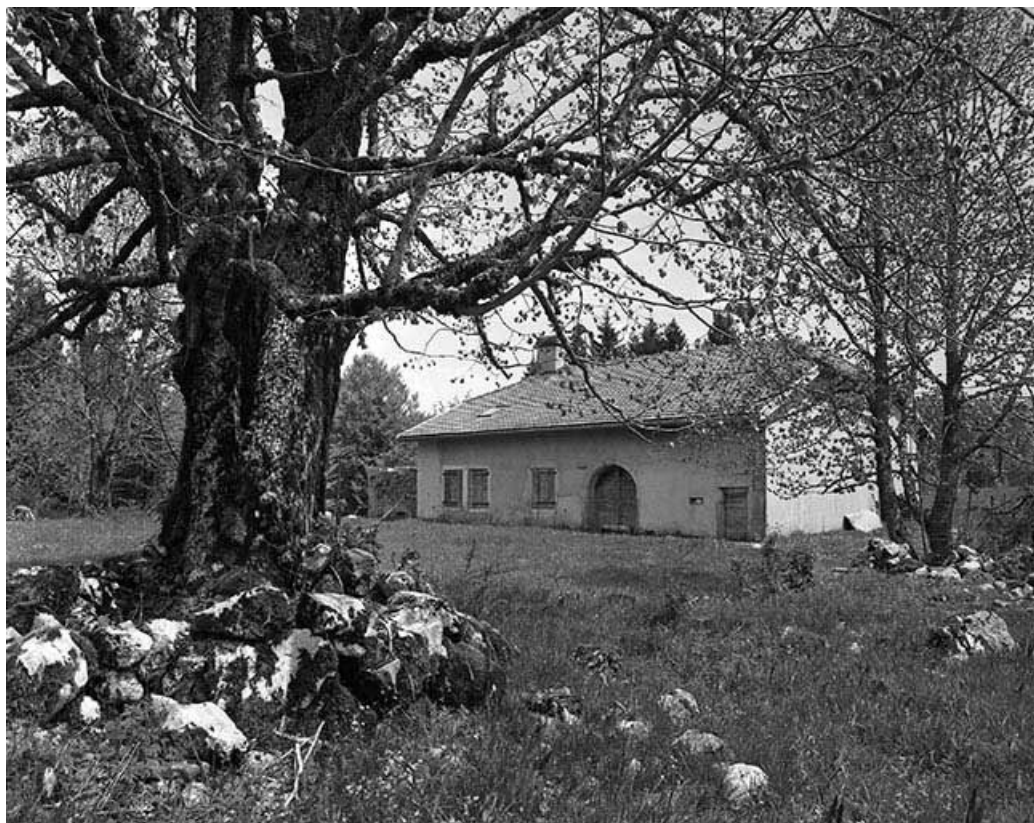
Vue éloignée de la façade postérieure.
