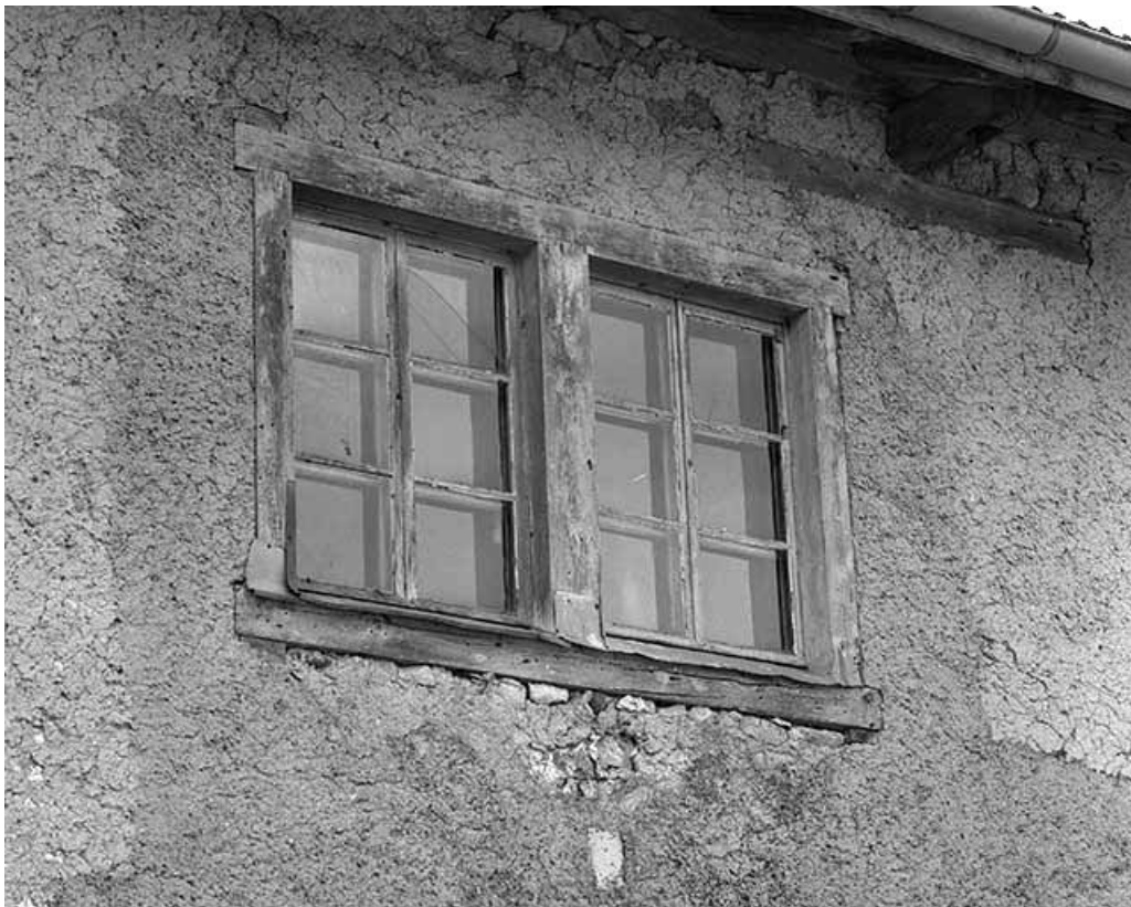
Fenêtre double sur la façade postérieure.
