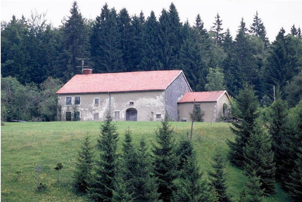
Vue éloignée de la façade postérieure.
