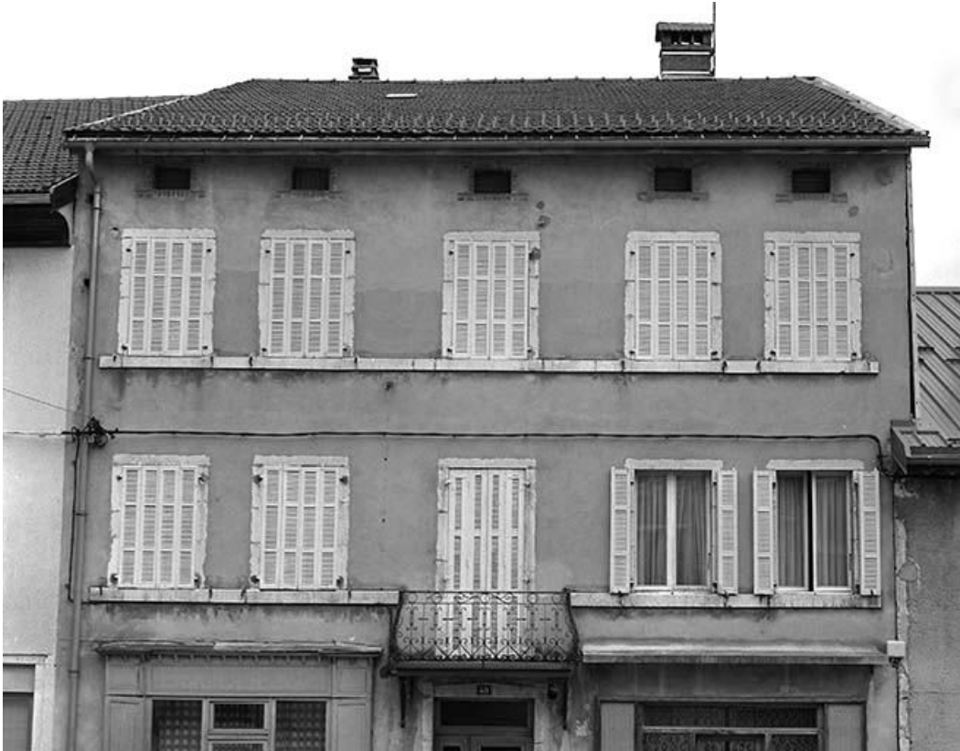
Façade antérieure, étages supérieurs.
