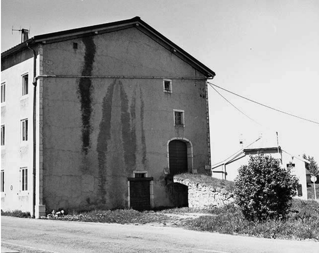
Façade postérieure et pont de grange.
