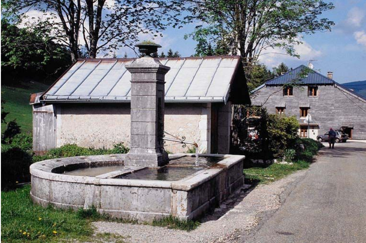
Vue générale de la fontaine.
