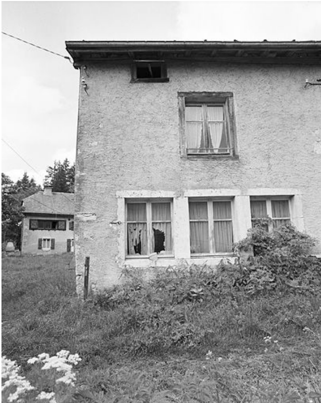
Les fenêtres de l'atelier.
