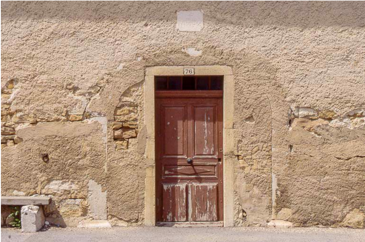
Porte sur la façade antérieure.
