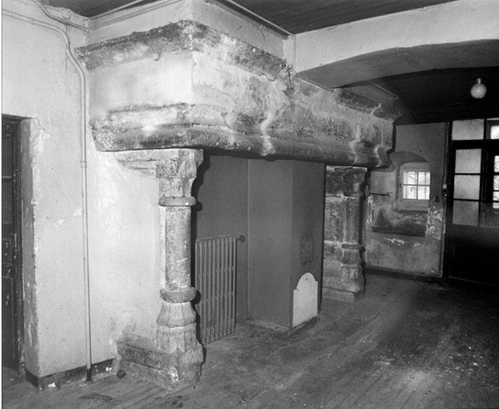
Vue intérieure, cheminée.
