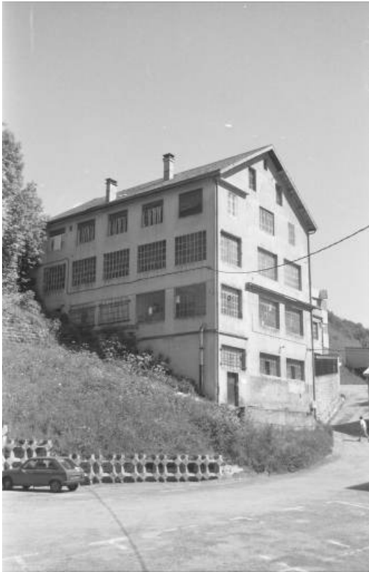
Façades postérieure et latérale droite.
