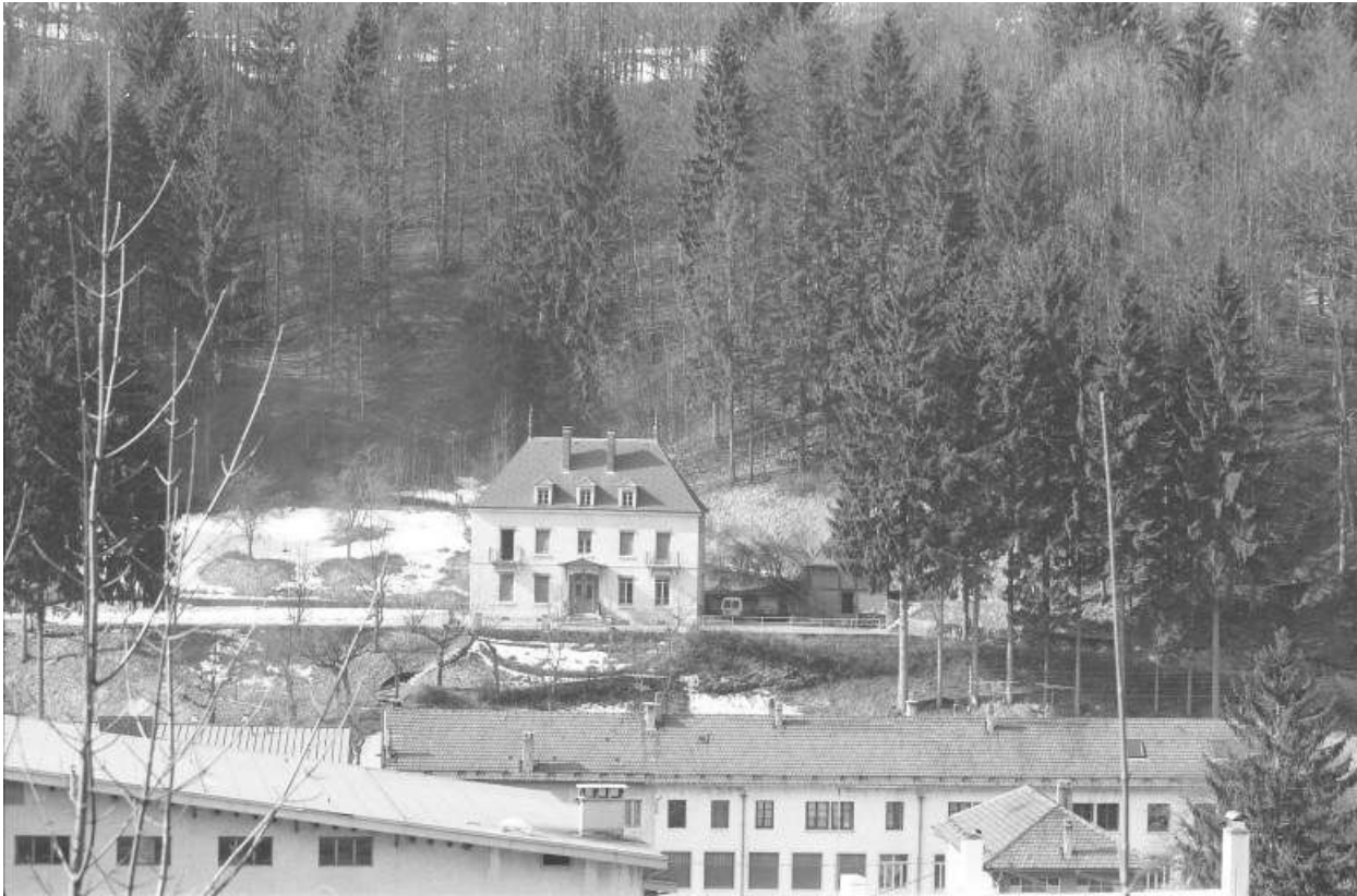
Vue d'ensemble du logement patronal.
