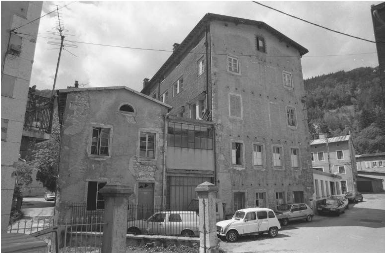
Bâtiment 6-8 rue Victor Poupin : façade latérale gauche.
