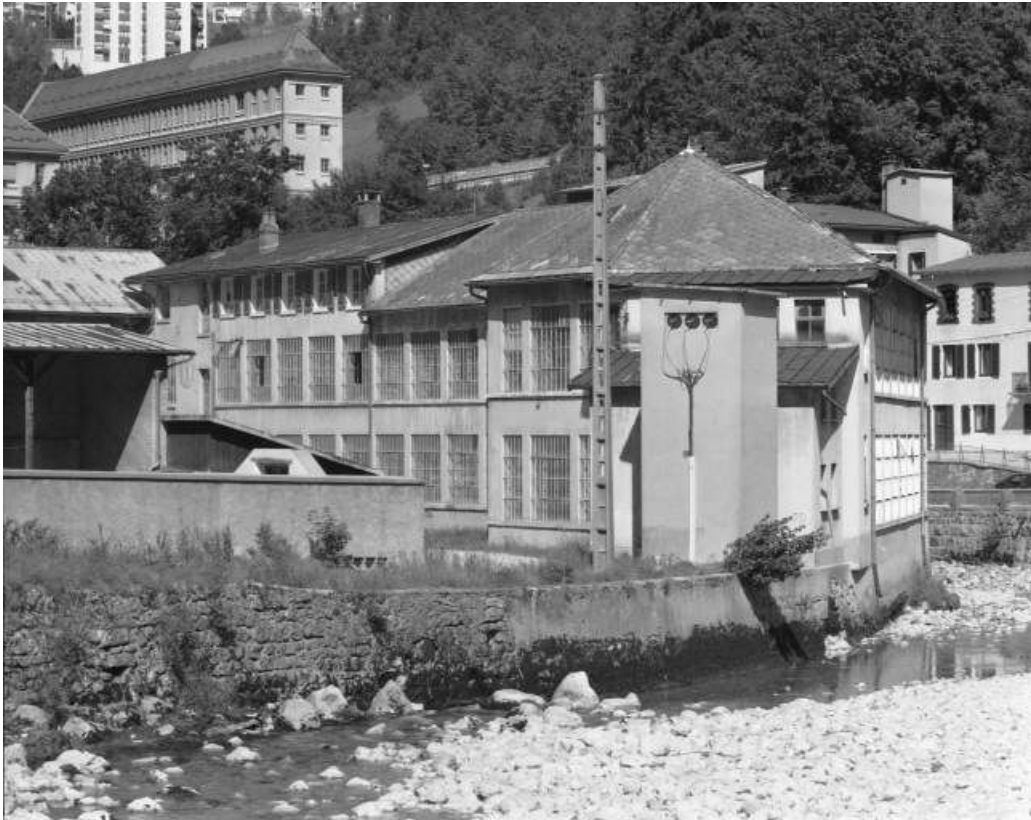
Ateliers de fabrication (1928-1929) : façade antérieure, extrémité amont.
