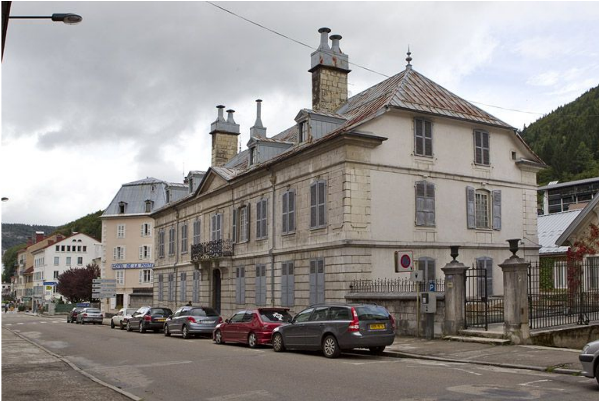
Façade du logement patronal, sur la rue.
