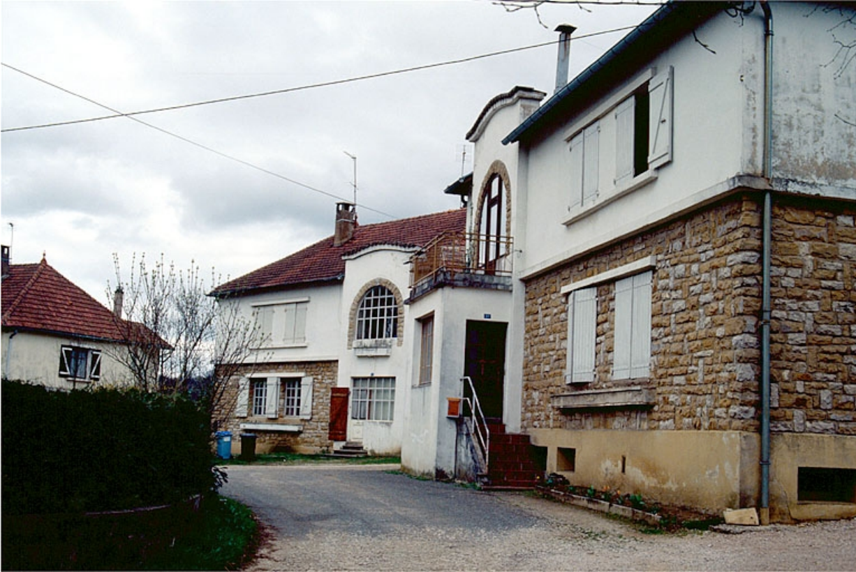
Maisons (G, H) : vue d'ensemble.
