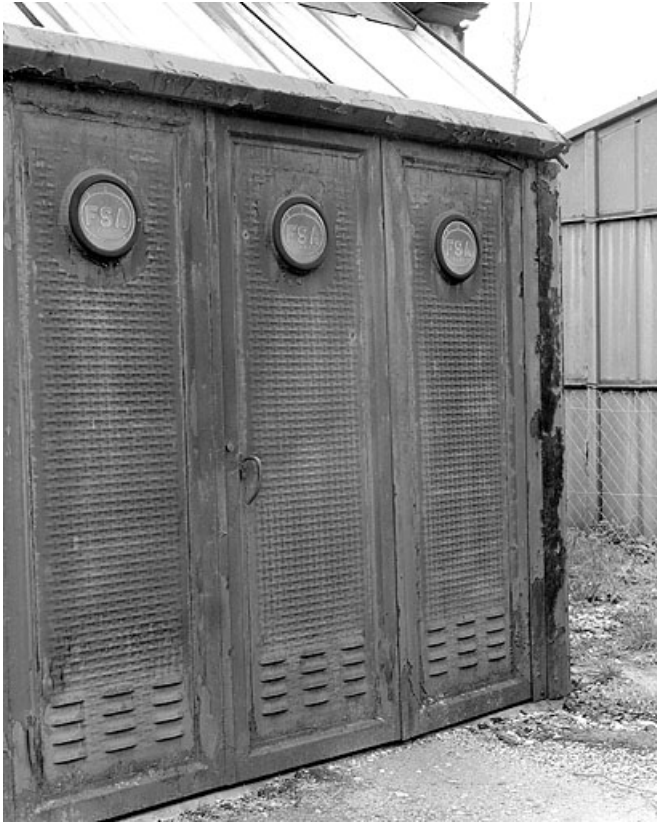
Remise d'automobile métallique : porte d'entrée.
