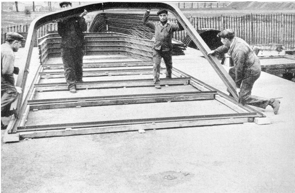
Montage d'un baraquement métallique dans les années 1940 : montage de l'armature.
