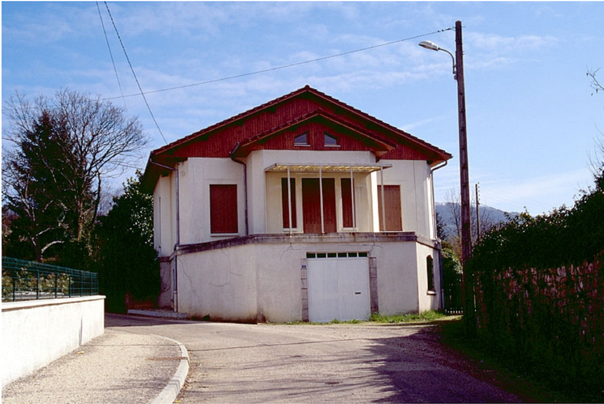
Maison métallique rue de Peroset : façade antérieure.
