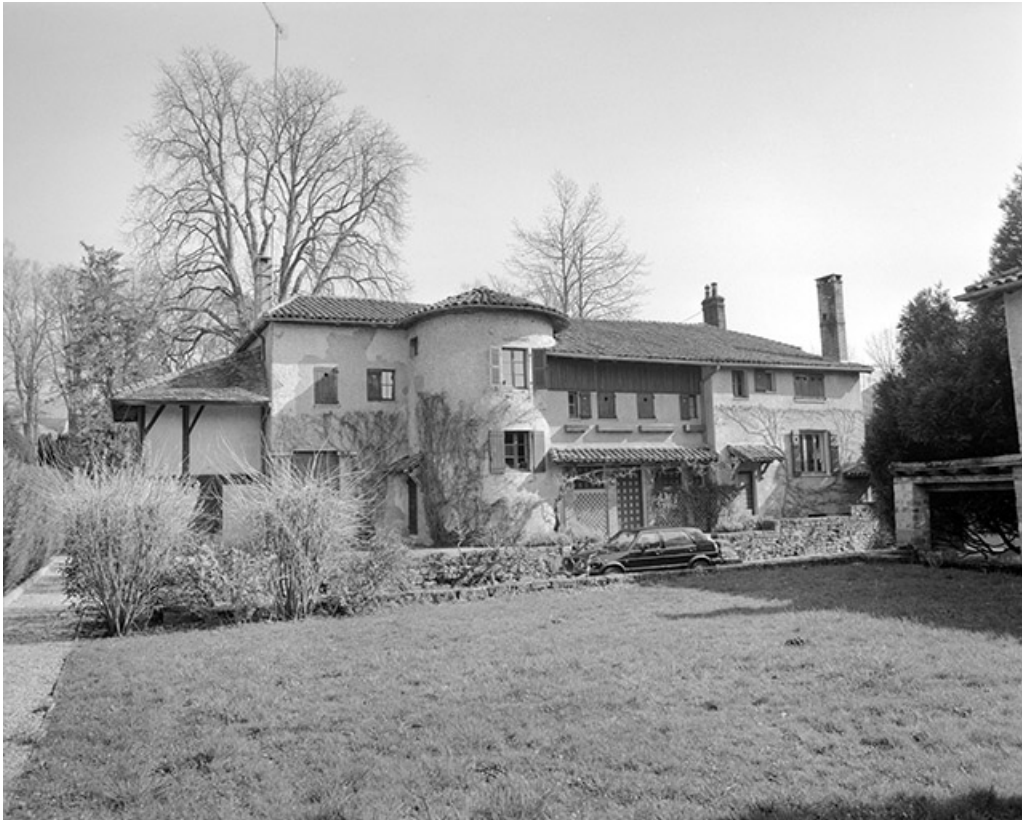
Façade antérieure du logement patronal (O).
