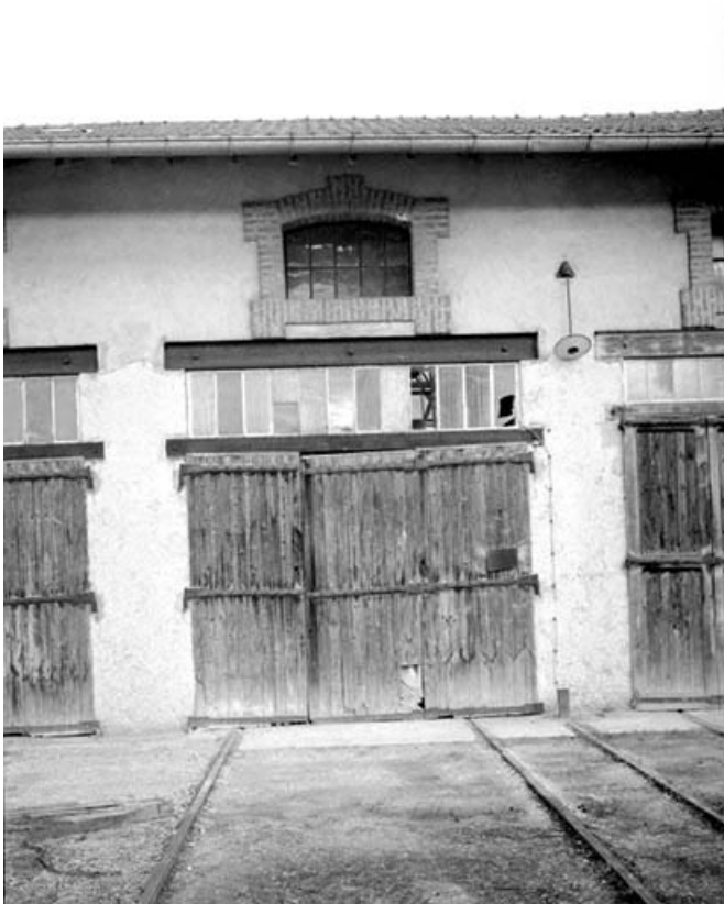
Détail d'une travée de la scierie.
