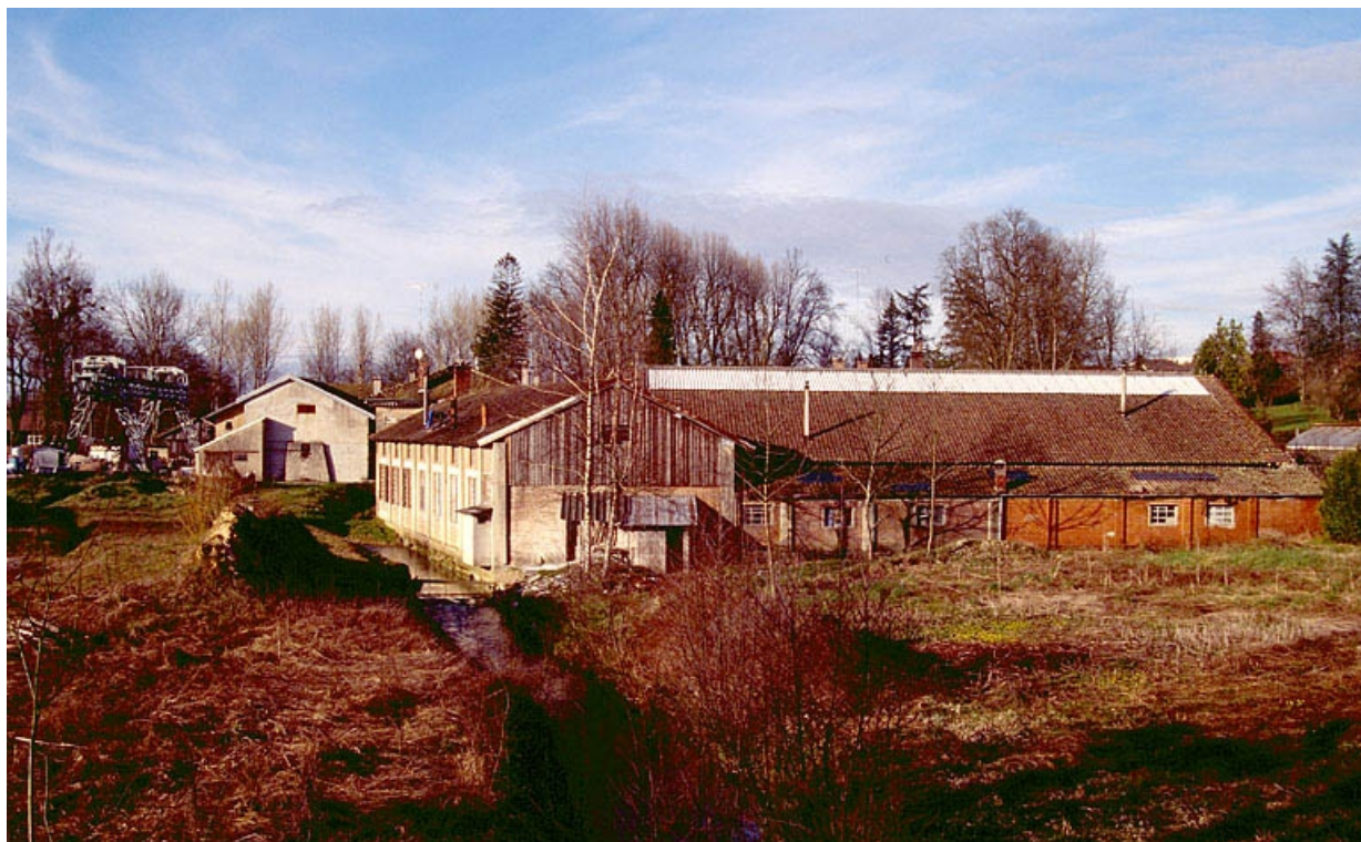
Vue d'ensemble depuis le sud.
