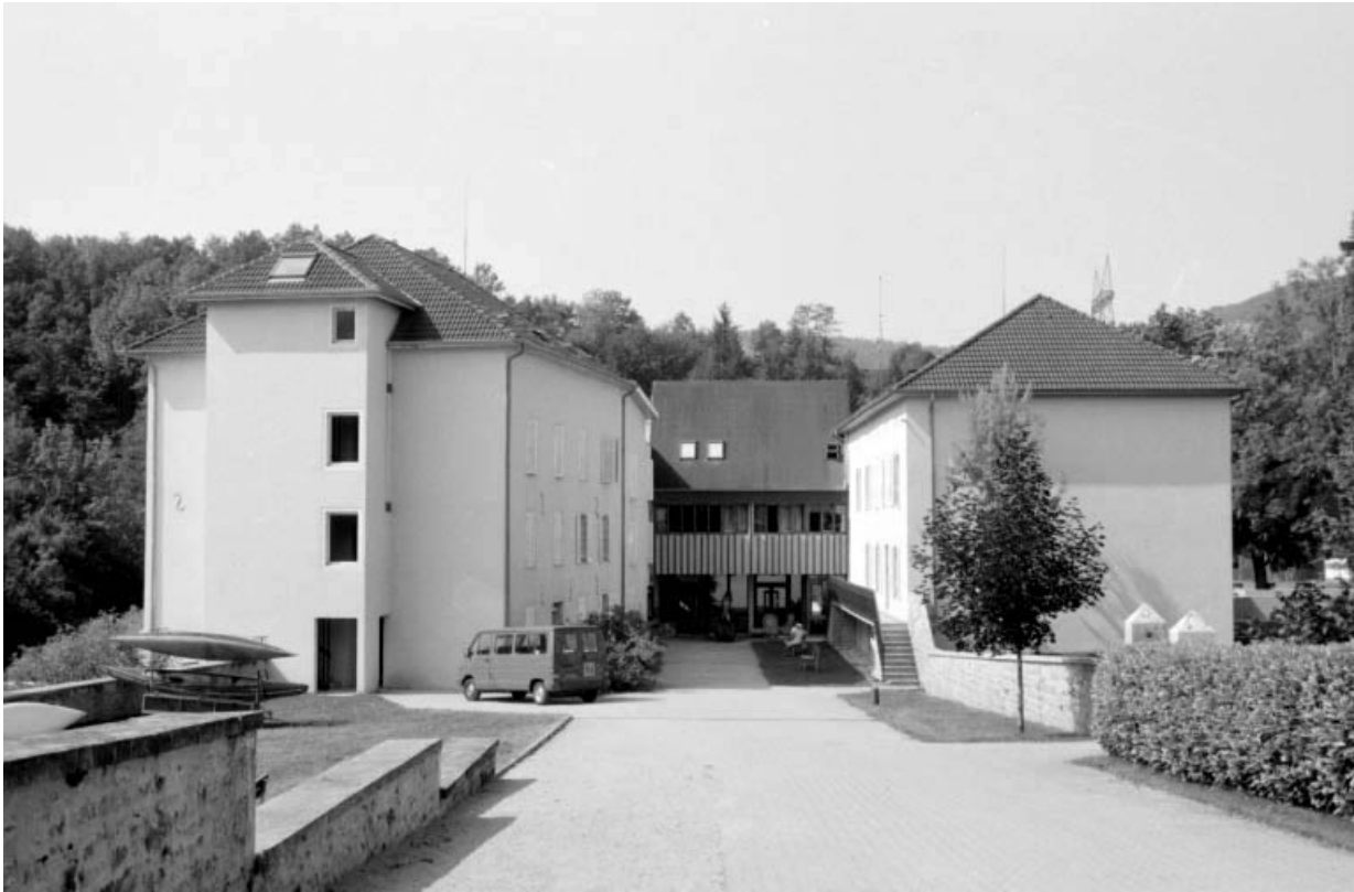
Atelier de fabrication et logement patronal.
