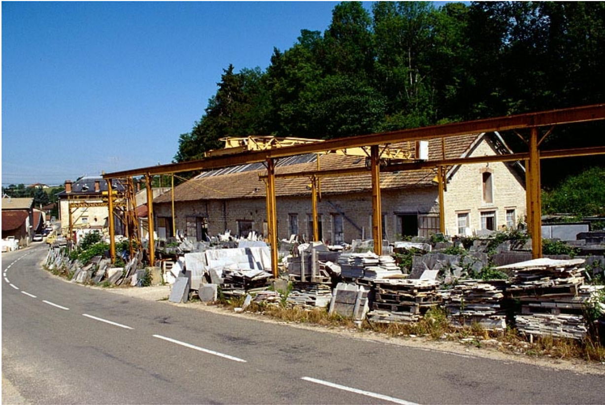
Atelier de fabrication, de trois quarts droite.
