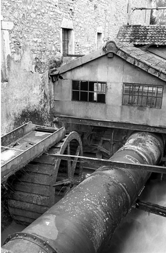
Roue hydraulique, conduite forcée et bâtiment d'eau.
