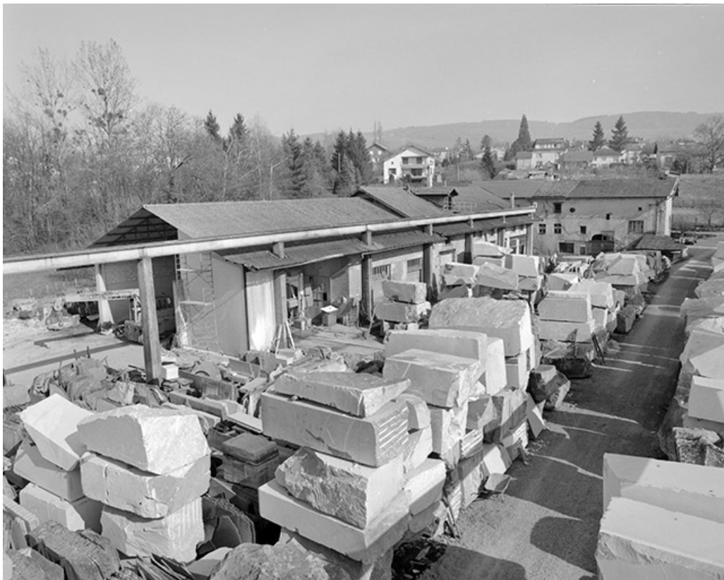
Vue d'ensemble des bâtiments depuis l'ouest.
