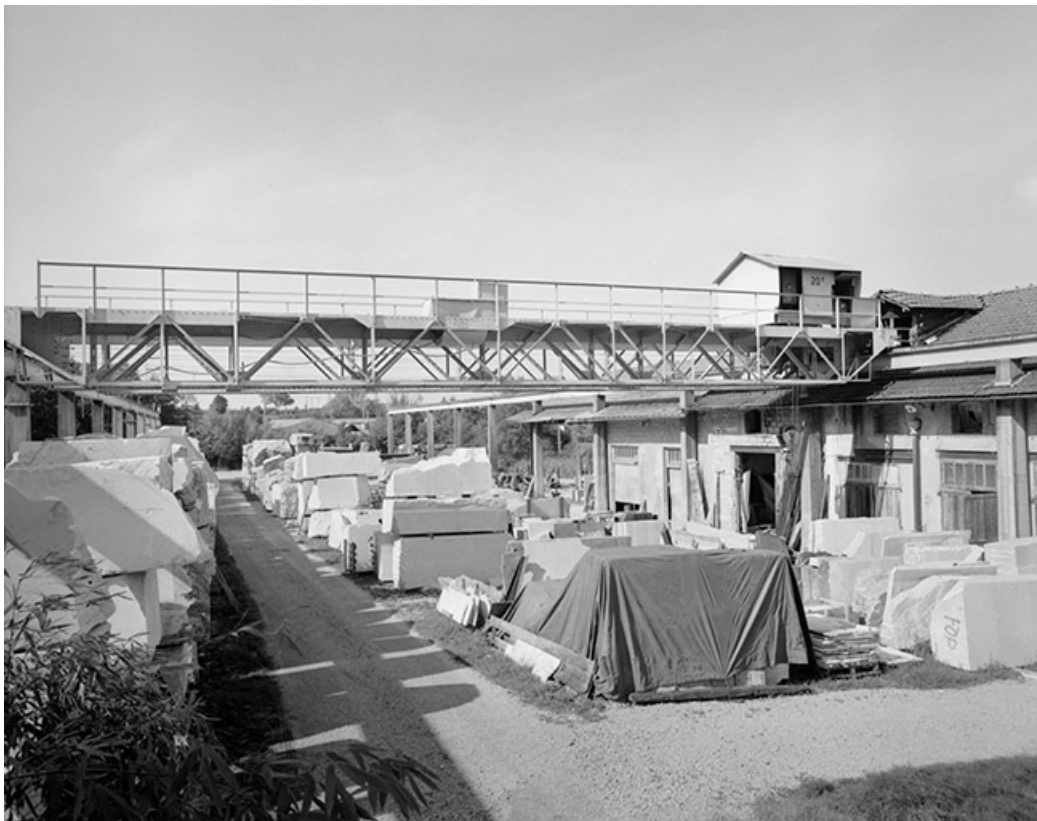
Atelier de fabrication et pont roulant.
