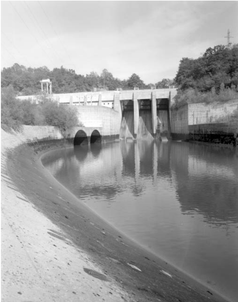
Evacuateur et bassin d'amortissement (cadrage vertical).
