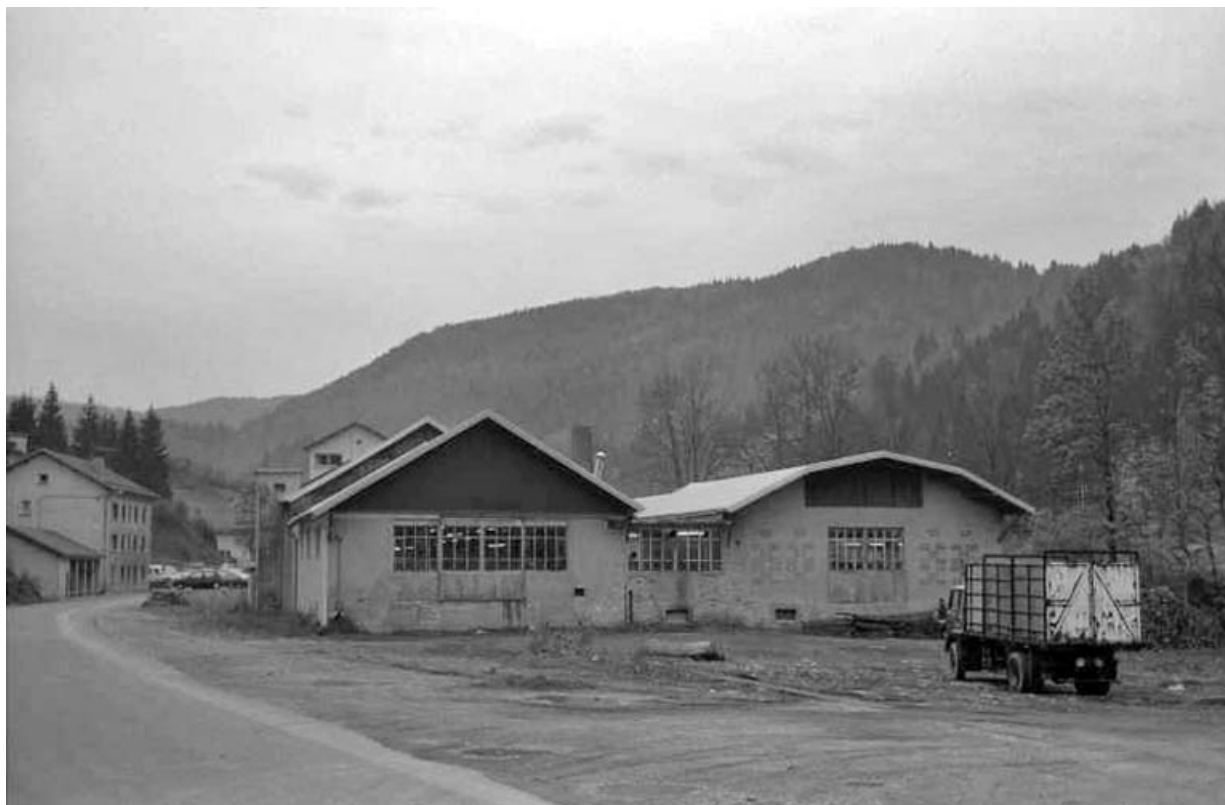
Vue d'ensemble de la façade postérieure.
