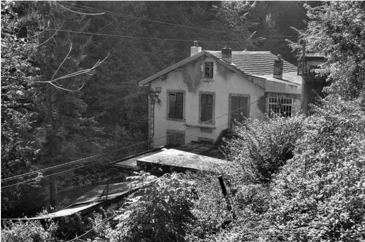
Façade antérieure, vue en plongée.
