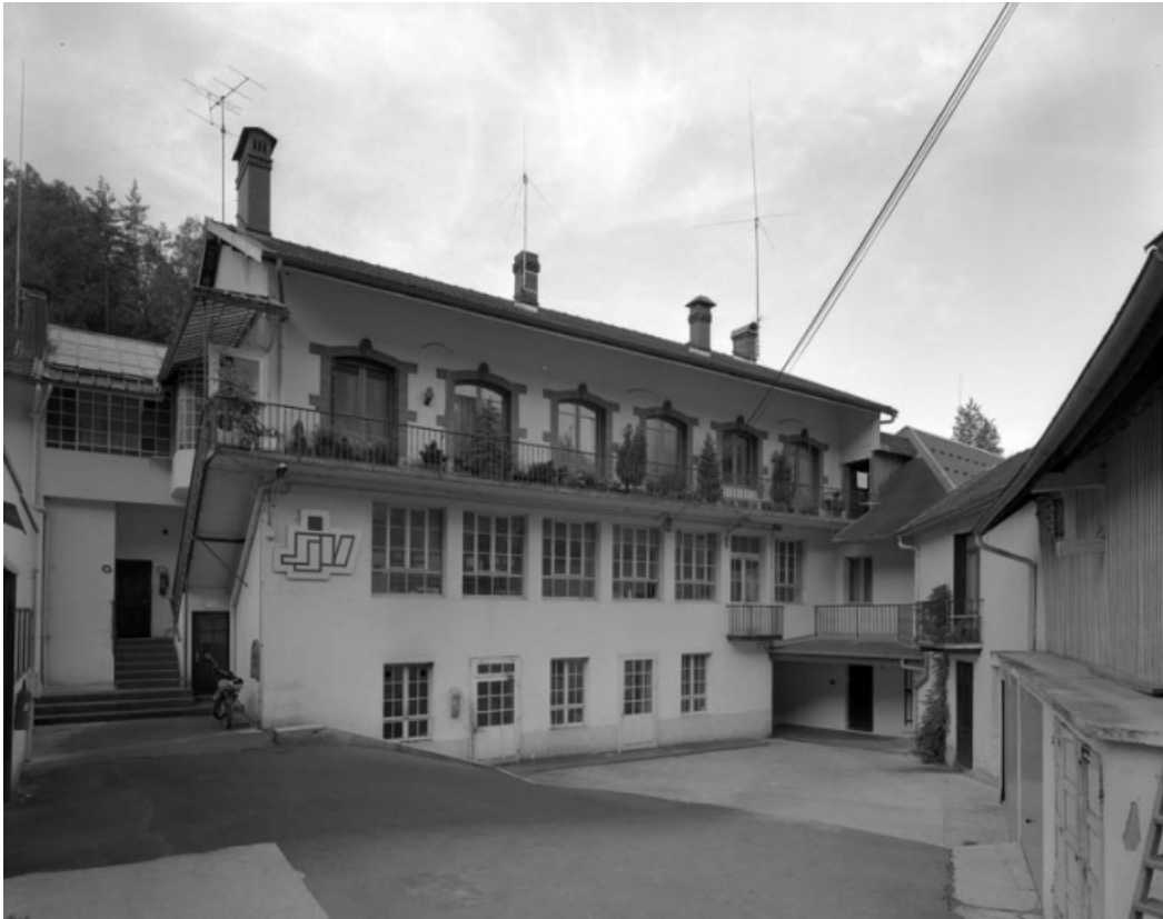
Façade sur cour du bâtiment de 1902.
