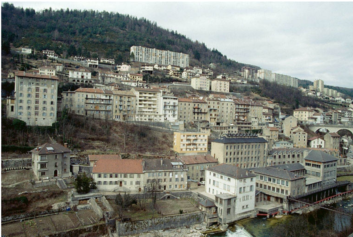
Vue d'ensemble du site depuis le sud-est.
