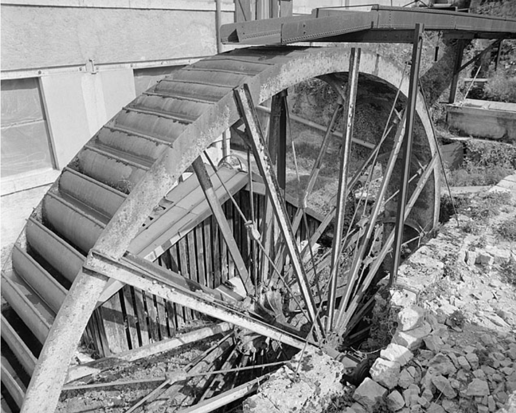
Détail de la roue hydraulique.
