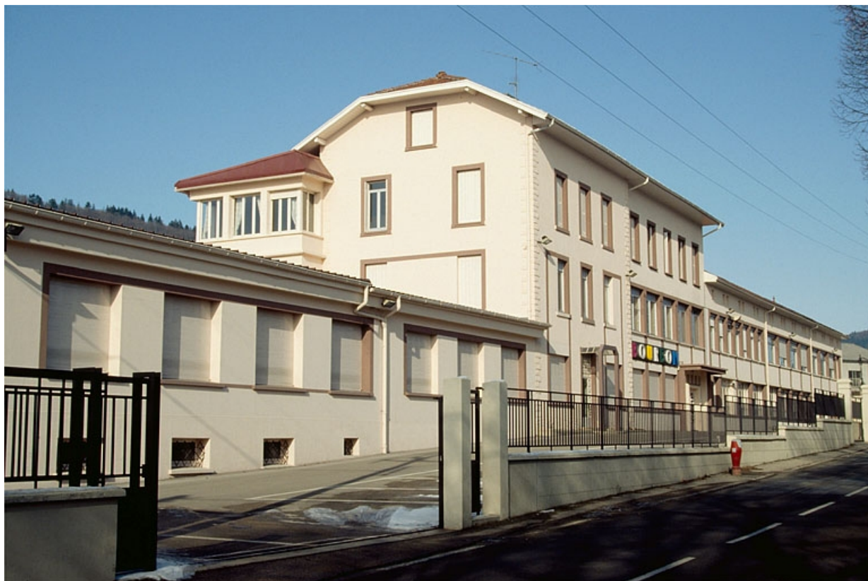
Bureaux, logement patronal et atelier de fabrication.
