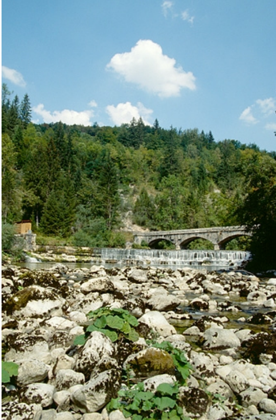
Le barrage, vu de l'aval.
