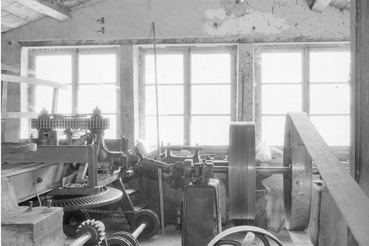
Transmission entre la turbine et la dynamo.
