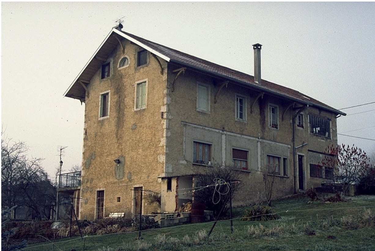
Façades postérieure et latérale gauche.
