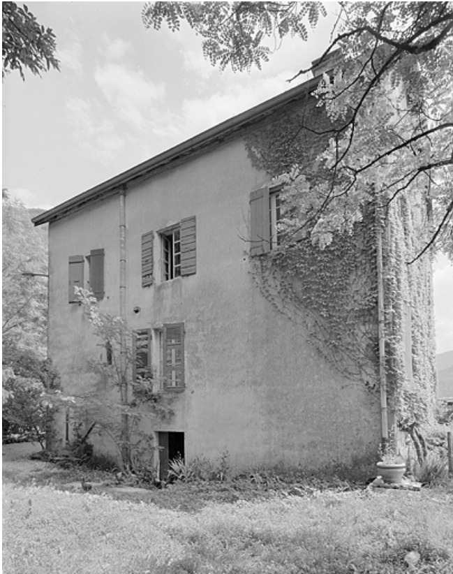
Façade droite avec accès au sous-sol.
