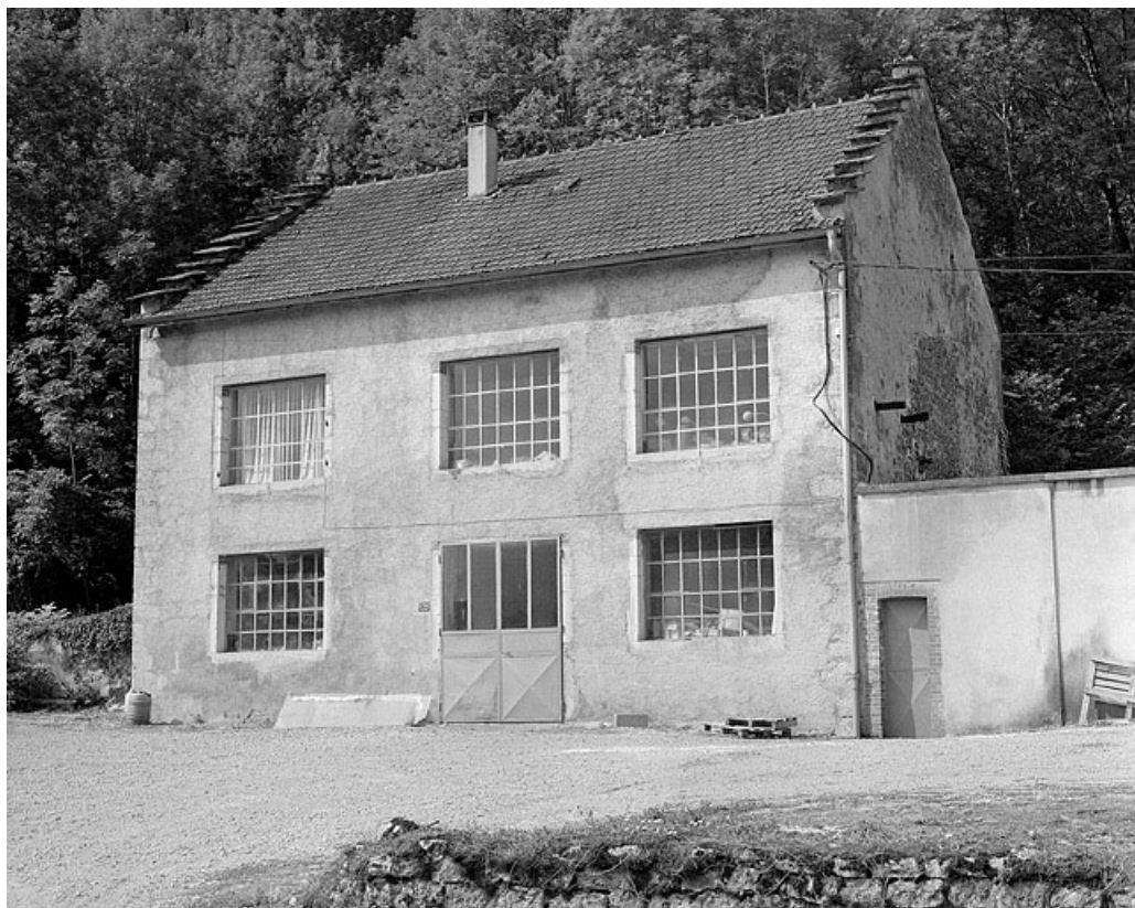
Façade antérieure du moulin.
