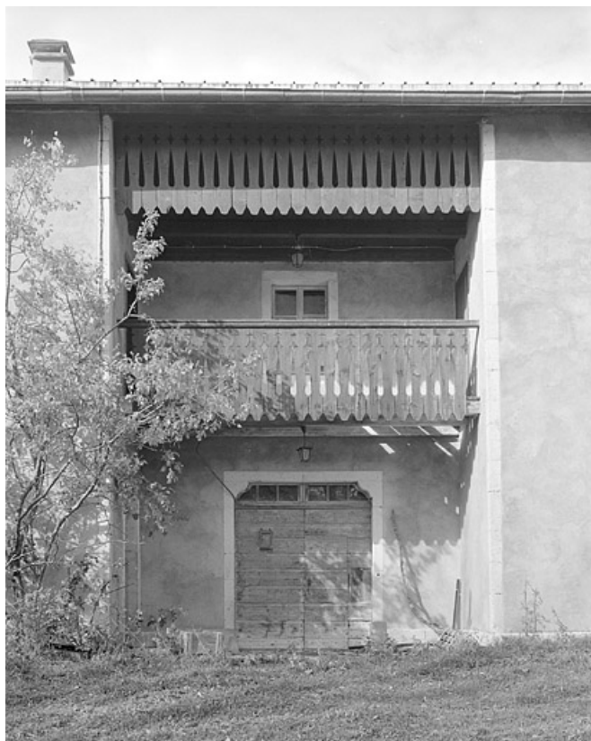
Galerie centrale sur la façade antérieure.
