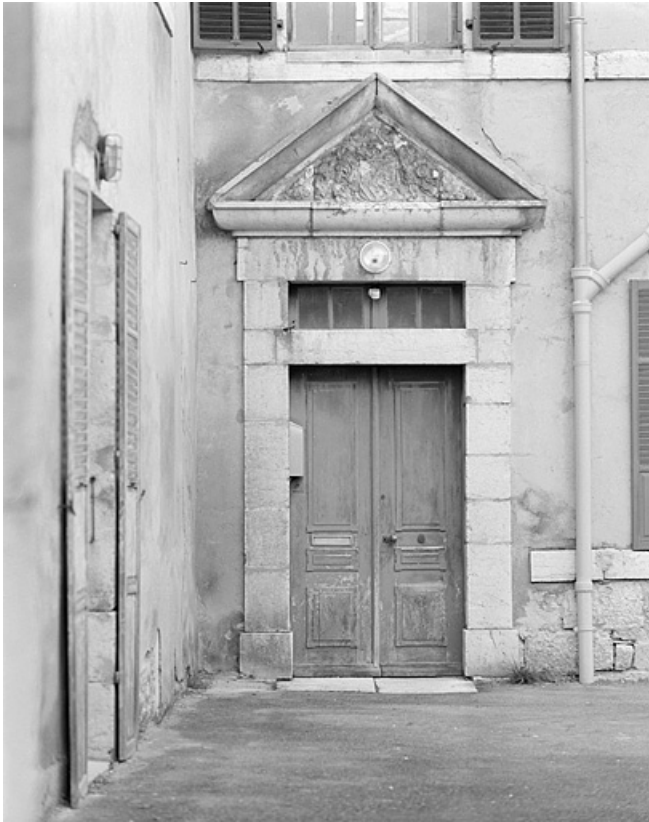
La porte d'entrée de l'ancien presbytère.
