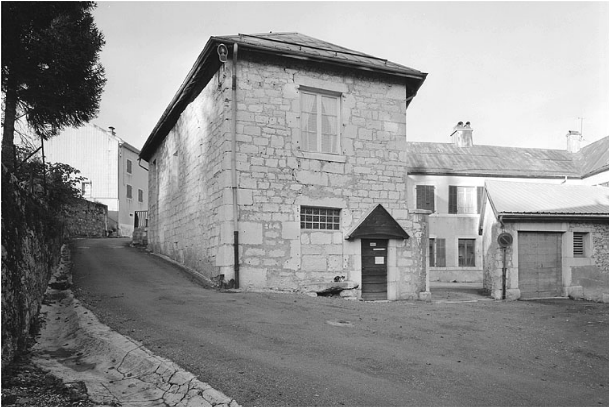
Vue générale, face sud-ouest.
