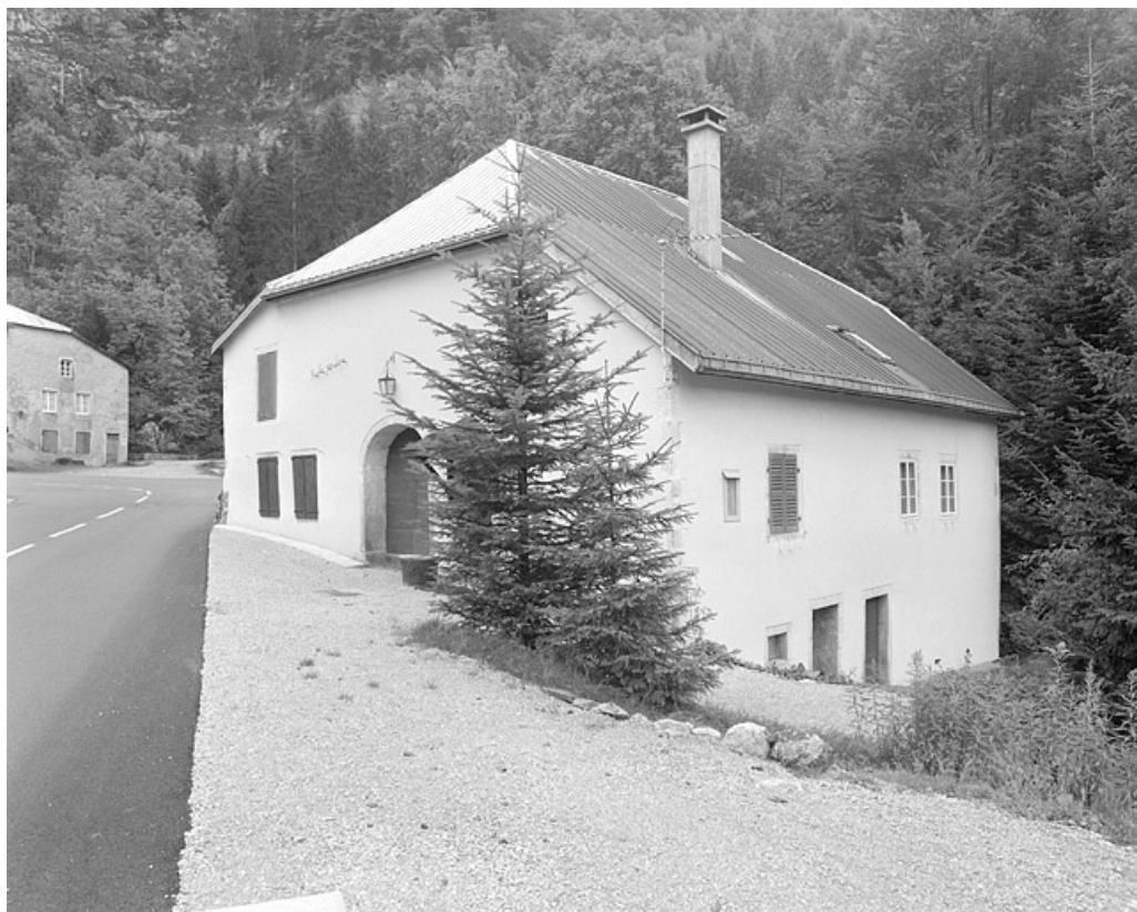
Façades nord-est et nord-ouest.
