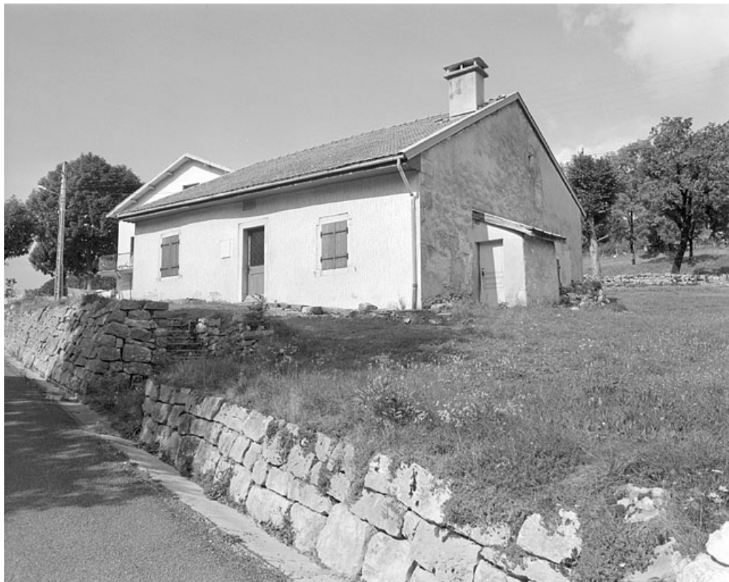
Façade antérieure et face droite.
