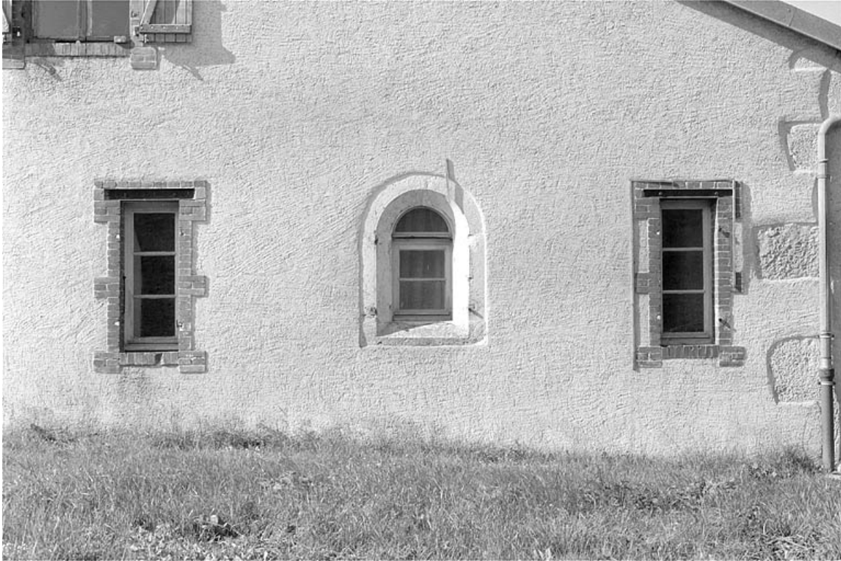
Détail des fenêtres de la fromagerie.
