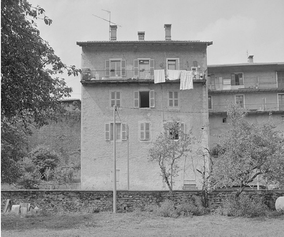
Façade postérieure de l'hôtel.
