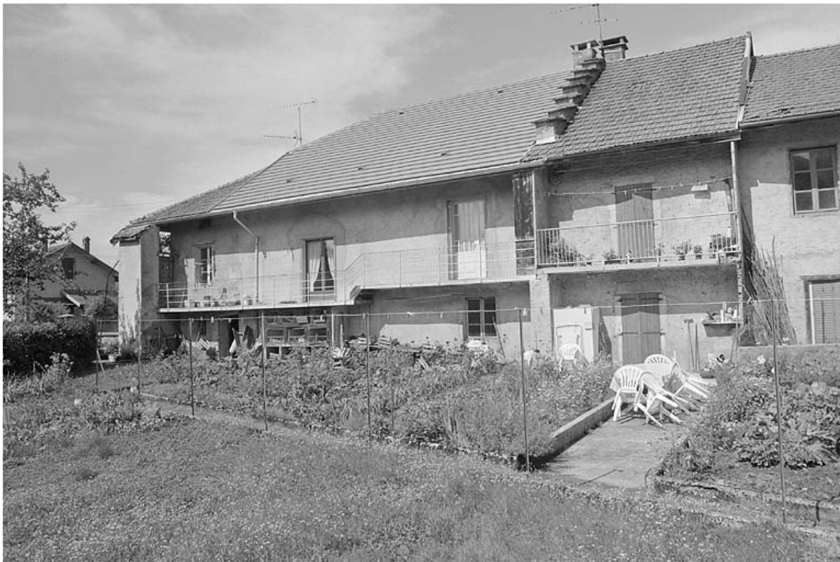
Façade postérieure de la ferme.
