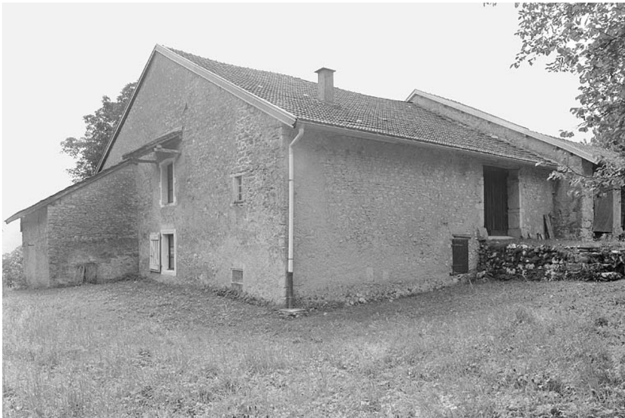
Face droite et façade postérieure.
