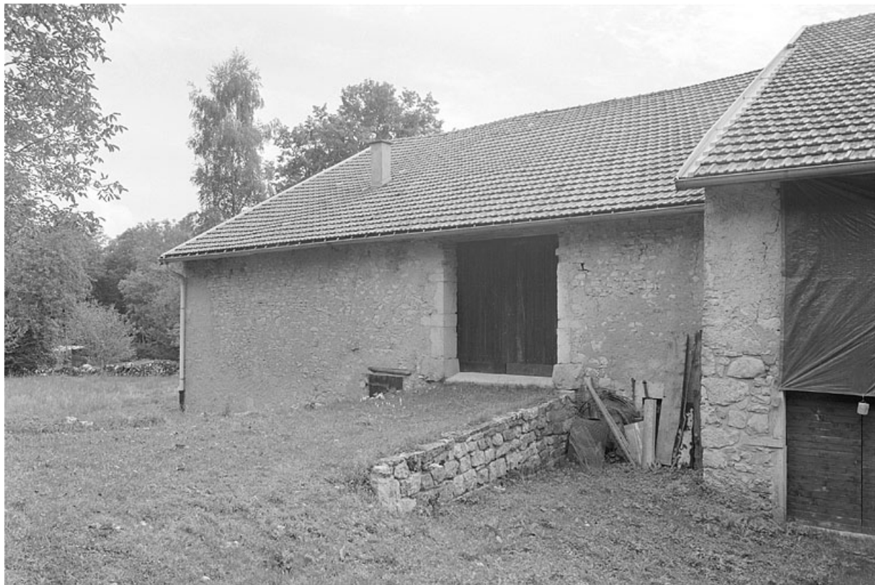
Façade postérieure, grange haute.
