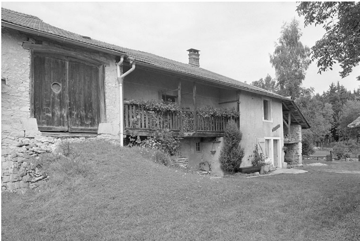
Façade antérieure, balcon en galerie.
