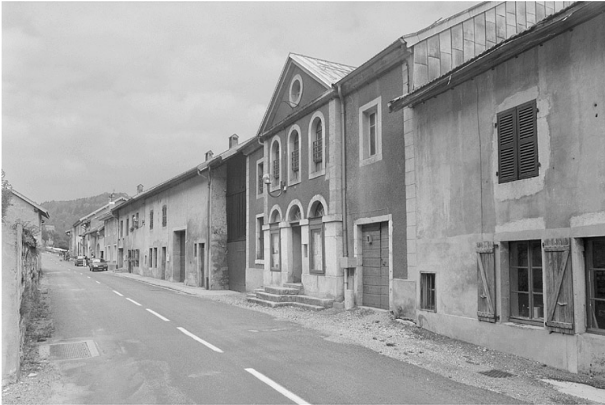
Vue depuis la rue principale.
