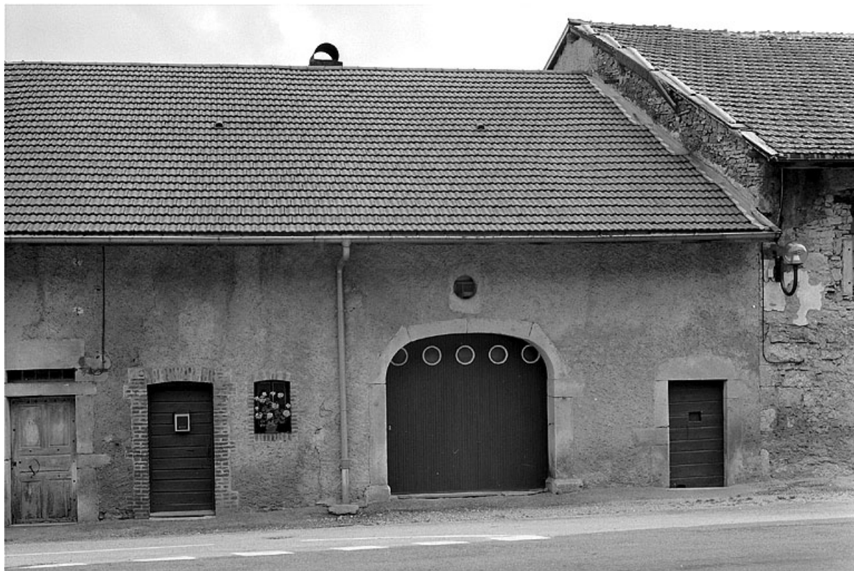
Façade sur la rue.
