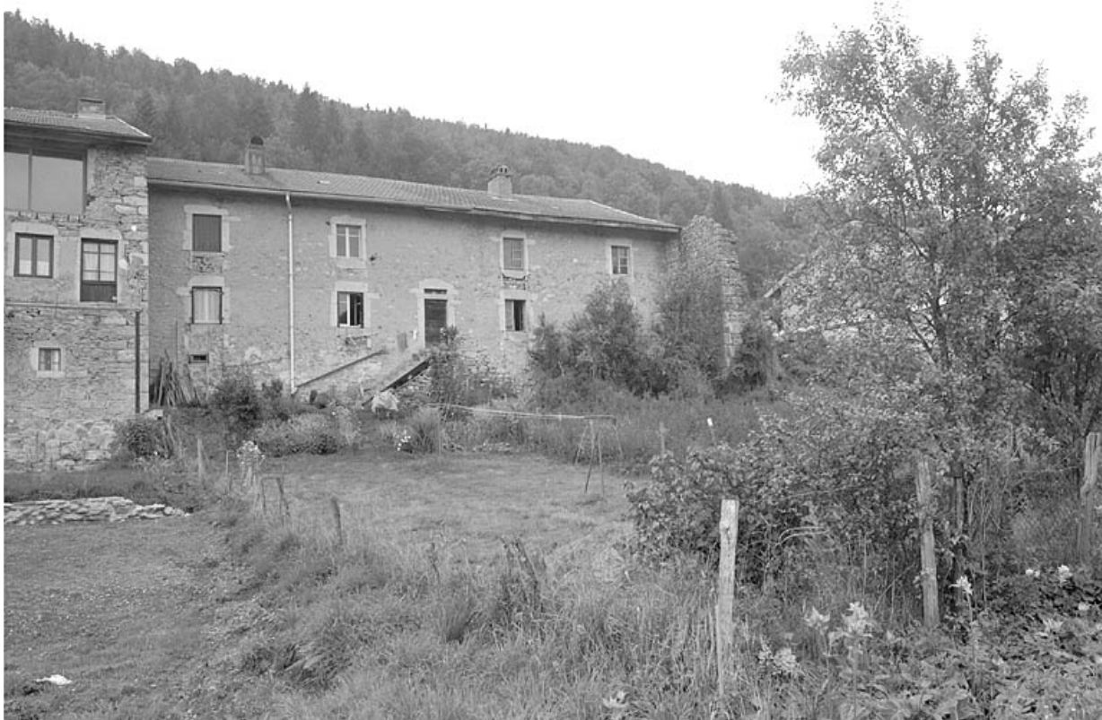
Façade postérieure, vue générale.
