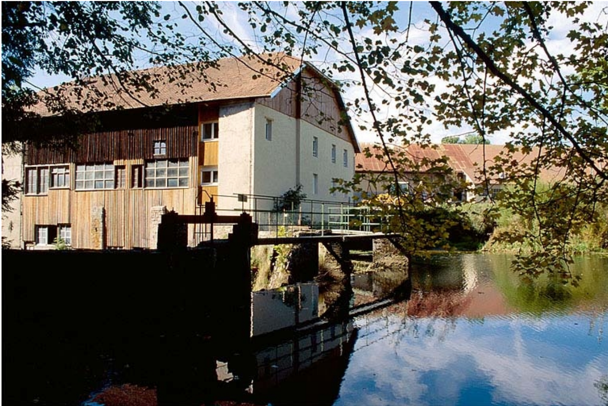
Au premier plan, bassin de retenue.
