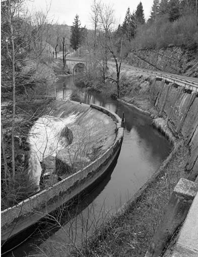
Canal d'amenée de la centrale.
