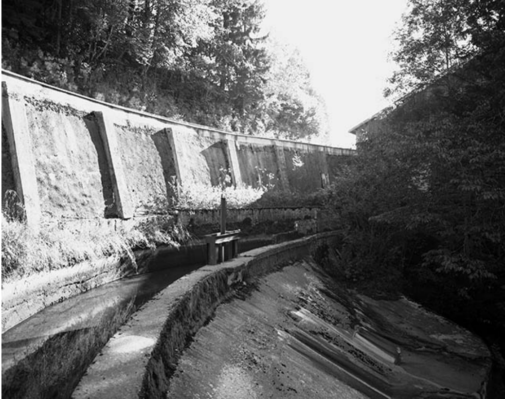
Canal d'amenée et déversoir du barrage.
