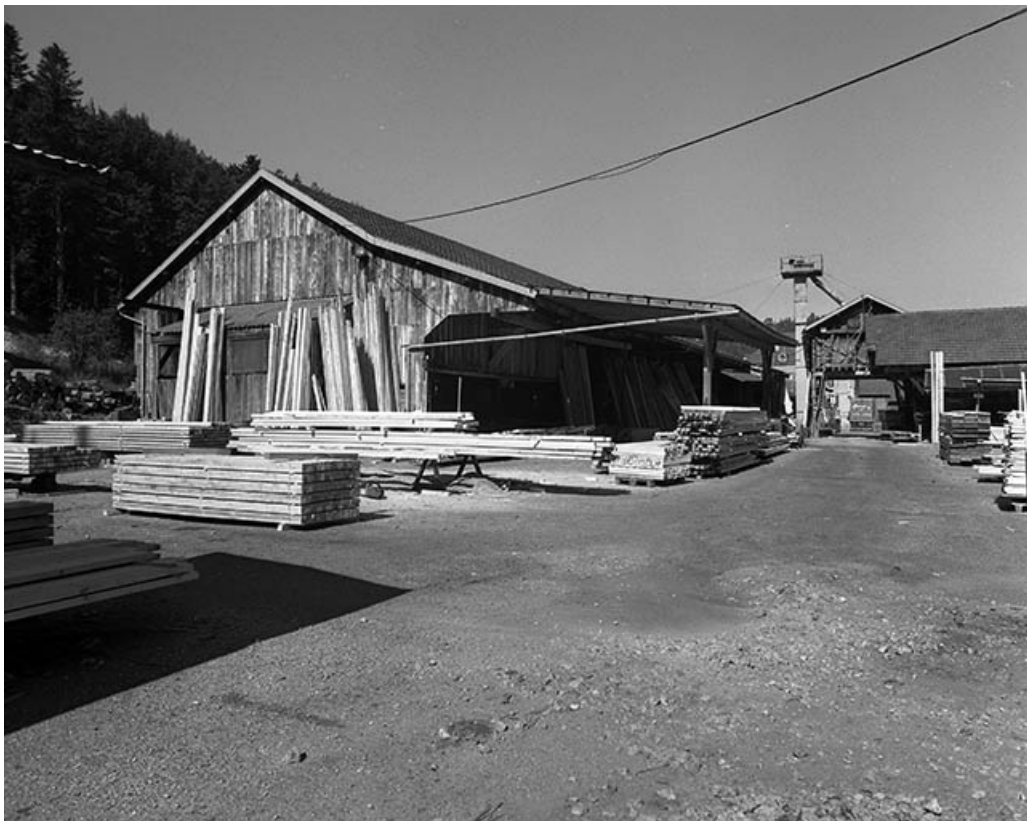
Atelier de fabrication (sciage) et magasin industriel.
