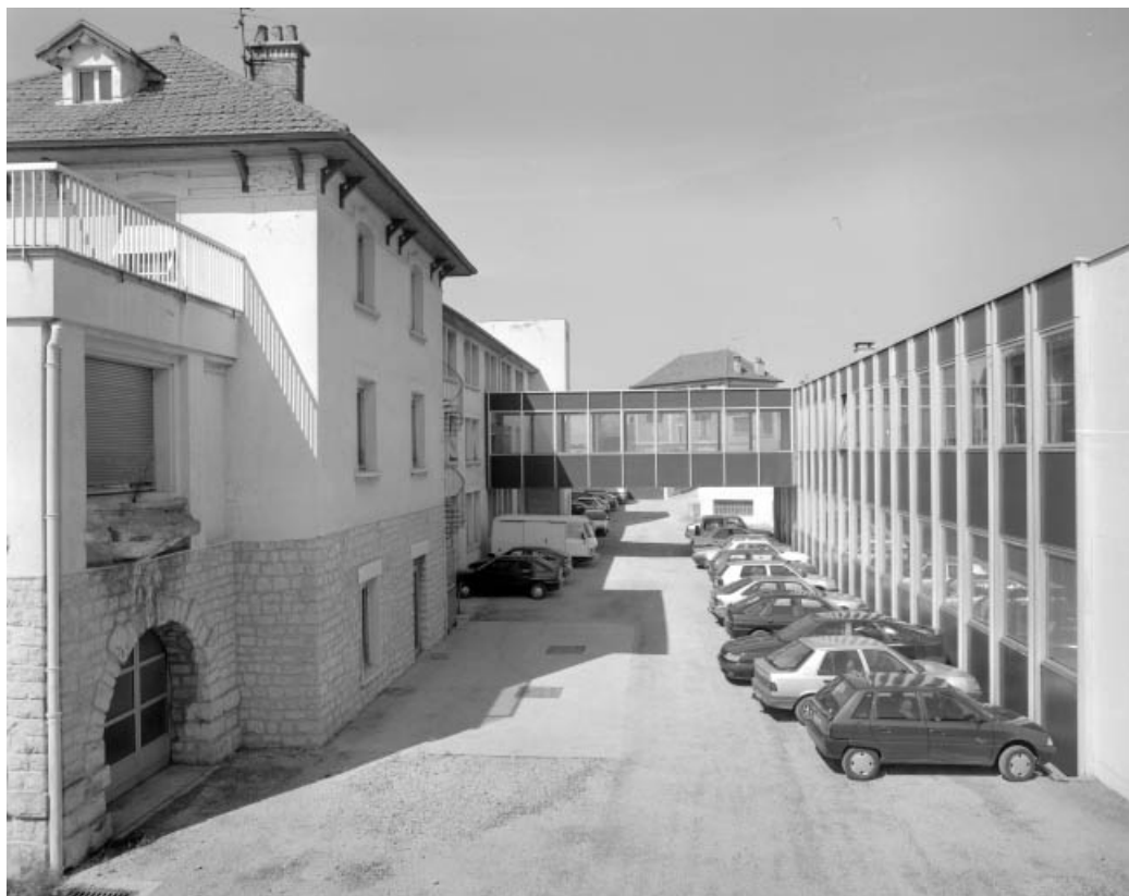
Ateliers de fabrication depuis le sud.
