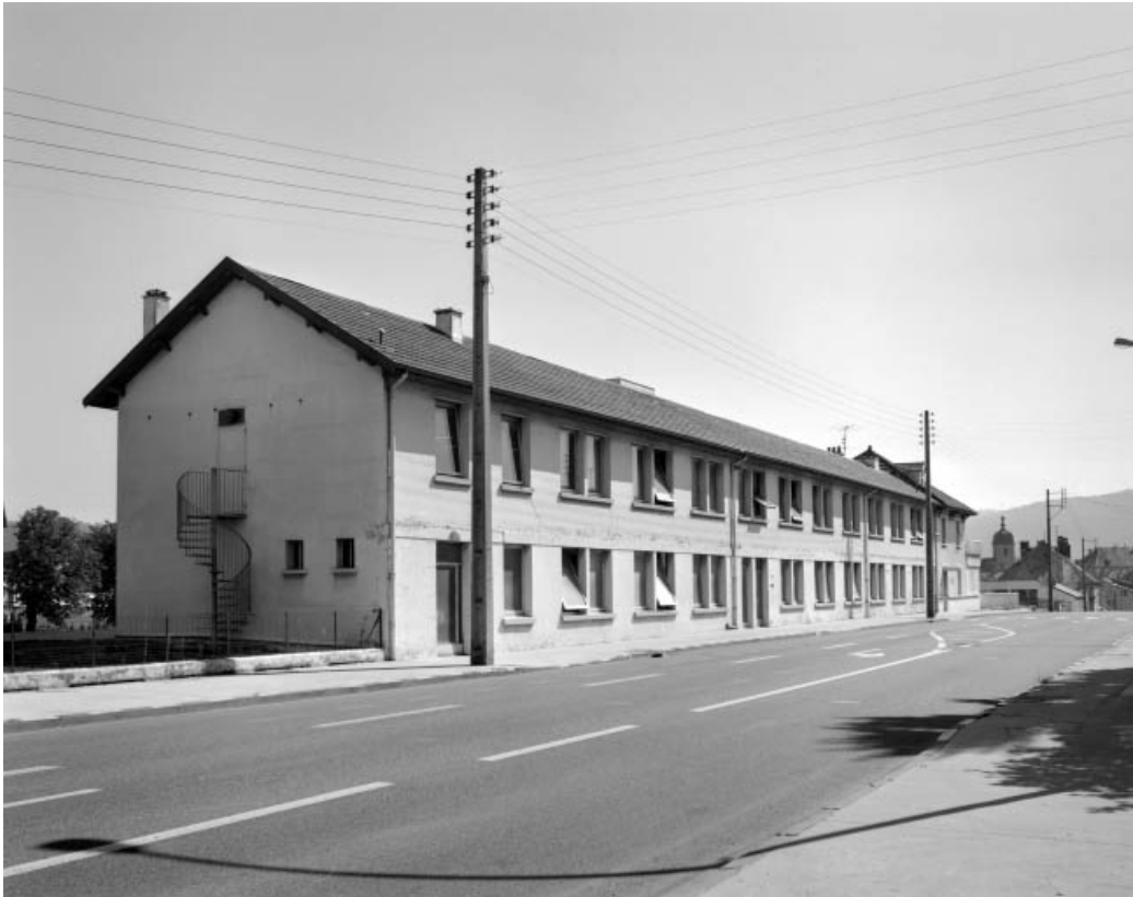
Atelier de fabrication depuis le nord-ouest.
