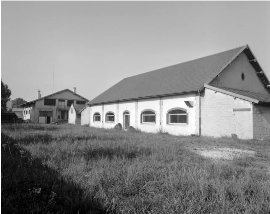
Façade postérieure de l'atelier de fabrication.
